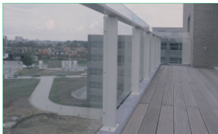
Vue intérieure d'un balcon pourvu d'une plaque en verre.
